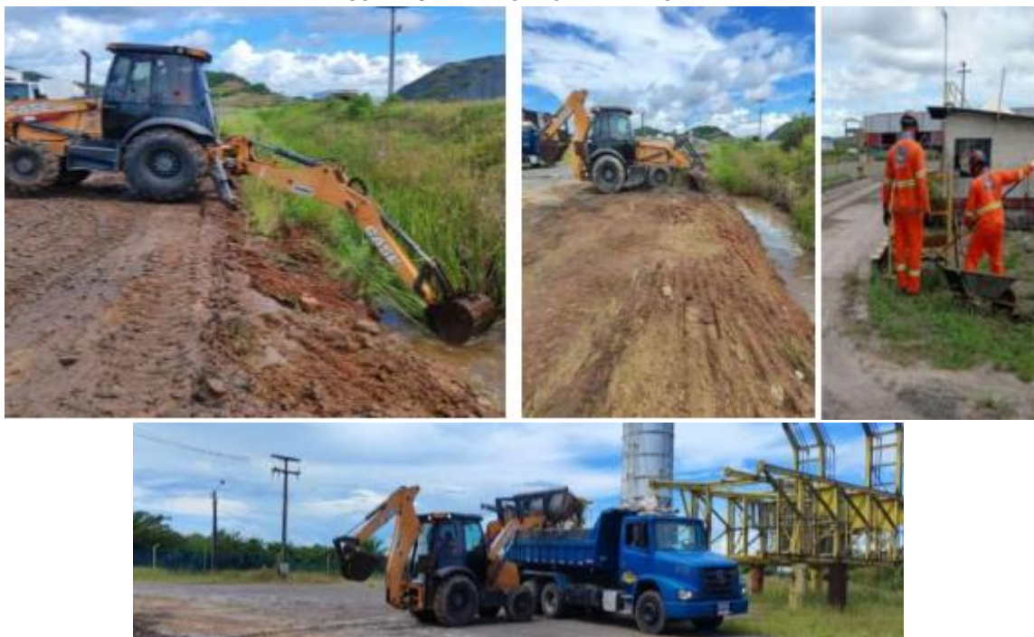
FIGURA 20 – MELHORIAS DA DRENAGEM.
