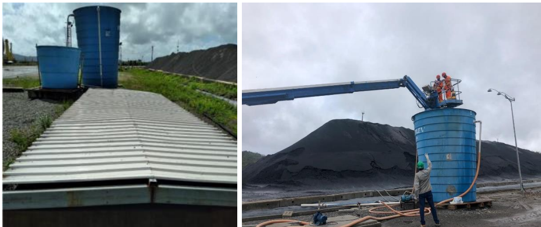
FIGURA 19 – SISTEMA DE DRENAGEM COMPLEMENTAR DOS PÁTIOS.
