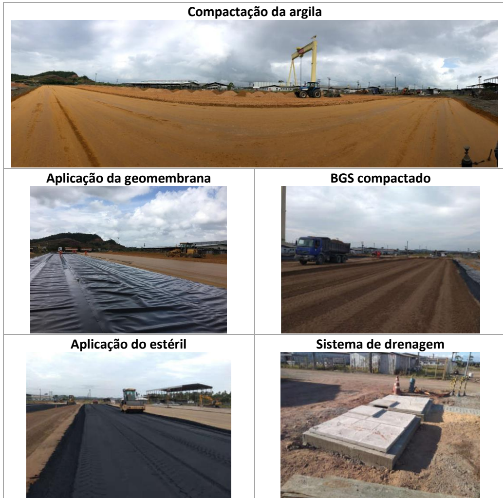
FIGURA 13 – CONSTRUÇÃO DO PÁTIO.
