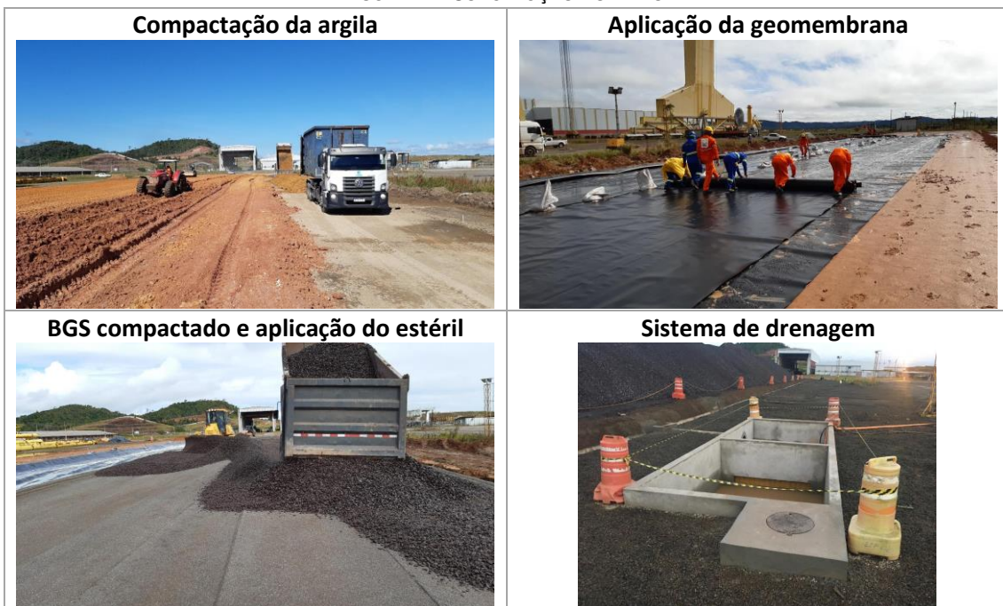
FIGURA 4 – CONSTRUÇÃO DO PÁTIO.
