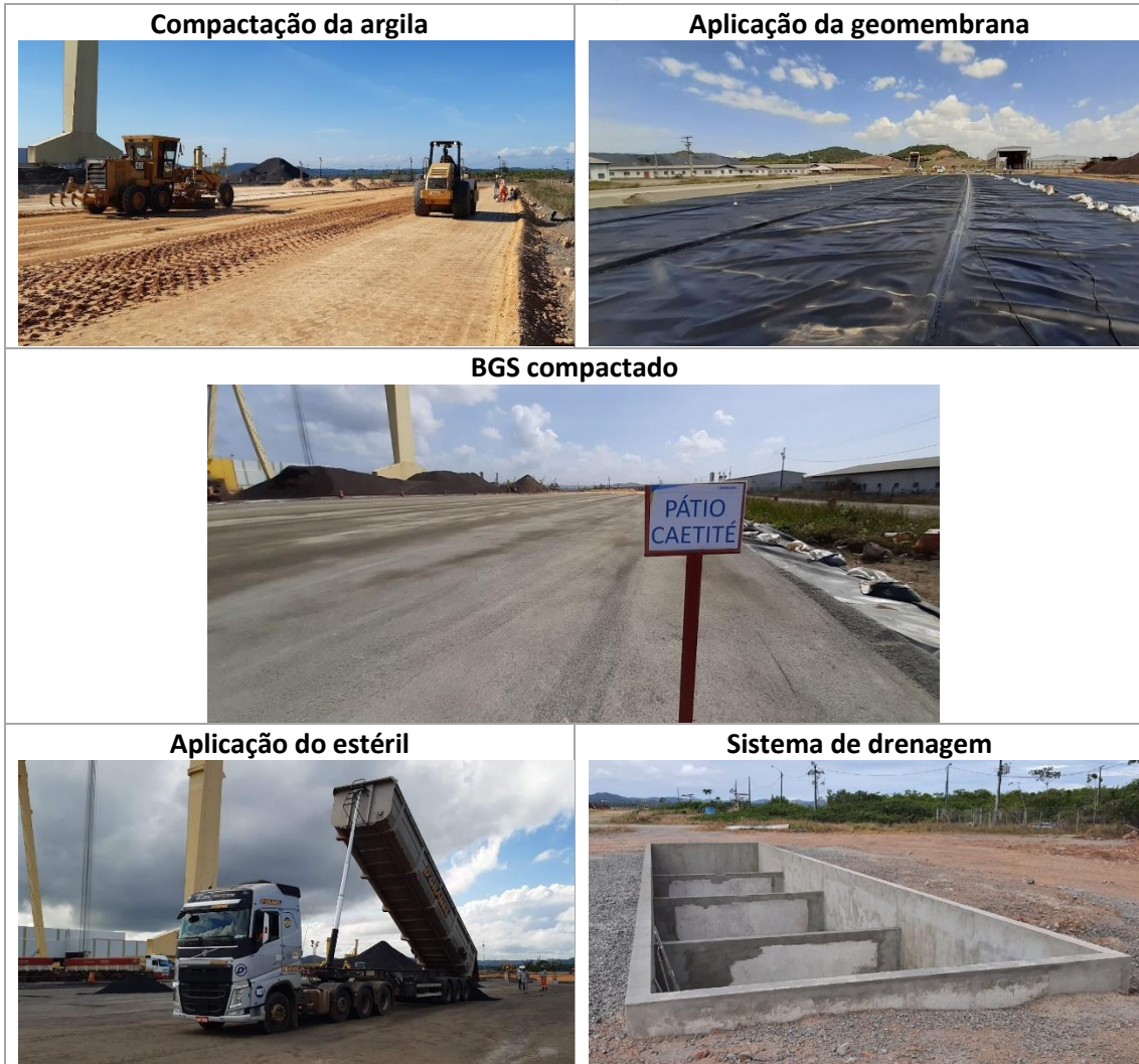
FIGURA 8 – CONSTRUÇÃO DO PÁTIO.
